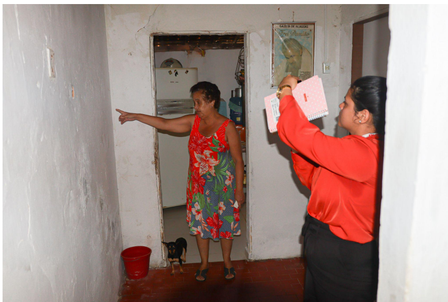
Senhora Jucidalva mostra os reparos feitos com a indenização paga pela Braskem, pelo Ilhamento socioeconômico, na Rua Faustino Silveira.
