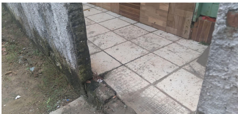
Muro de casa com inclinação para o lado da rua - Flexal de cima
