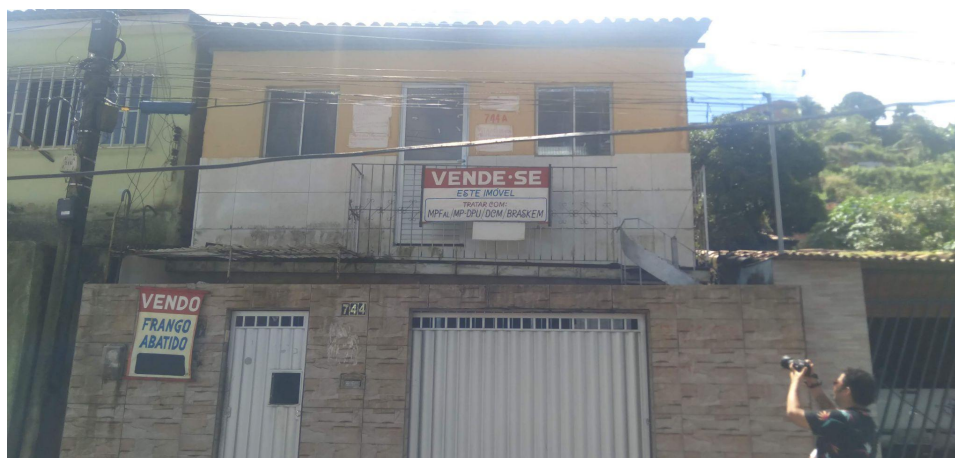
Casa do senhor José Ilton, nº 744 , localizada na rua Tobias Barreto
