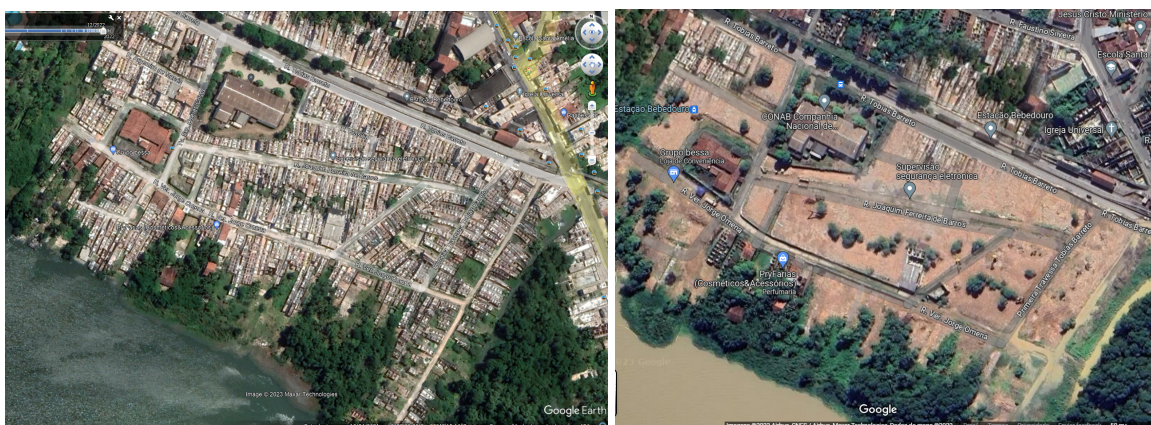
Figura 3: Comparação da área demolida
